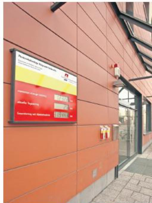
Eine Anzeigentafel am Eingang des Bürgeramts informiert zu Solaranlage auf dem Dach des Gebäudes Foto: Roland Heinrich
